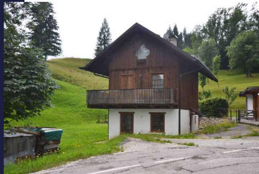
Foto - Stato di fatto
